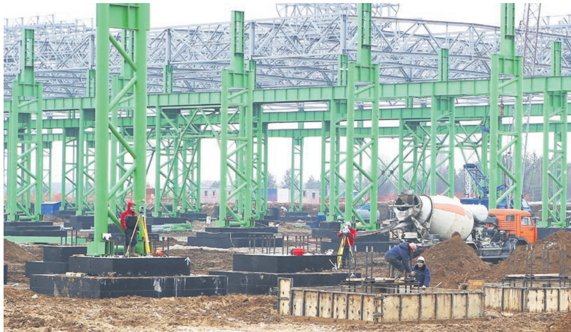
▲ В промзоне идет строительство нового цеха © ВАЛЕРИЙ ПОКУМЕЙКО
